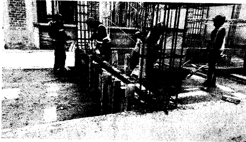
Foto 9: Vaciado de sobre cimientado armado en zona de maestranza.
