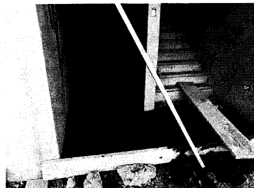
Fotografía N°06: vaciado de falso piso.
