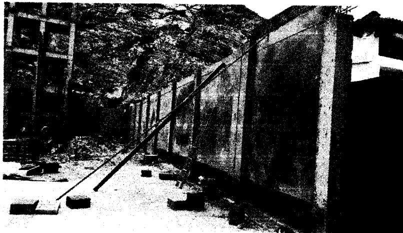
Foto 7: Tarrajeo de muros exteriores en cerco perimétrico en límite con lado Produmar.
