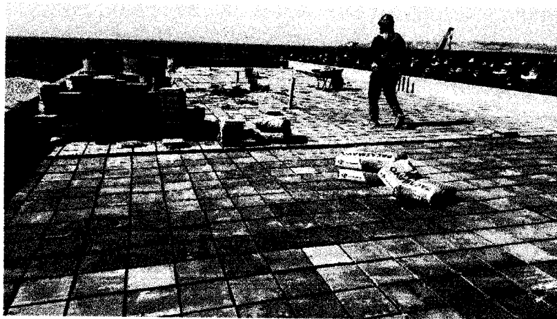
Foto 8: Asentado de ladrillo pastelero en zona de frío.
