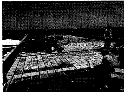
Fotografía N°11: colocación de ladrillos pasteleros en techos área Frio.
