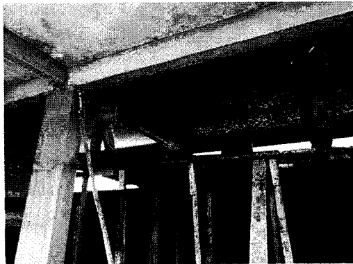
Fotografía N°03: tarrajeo de cielo raso.
